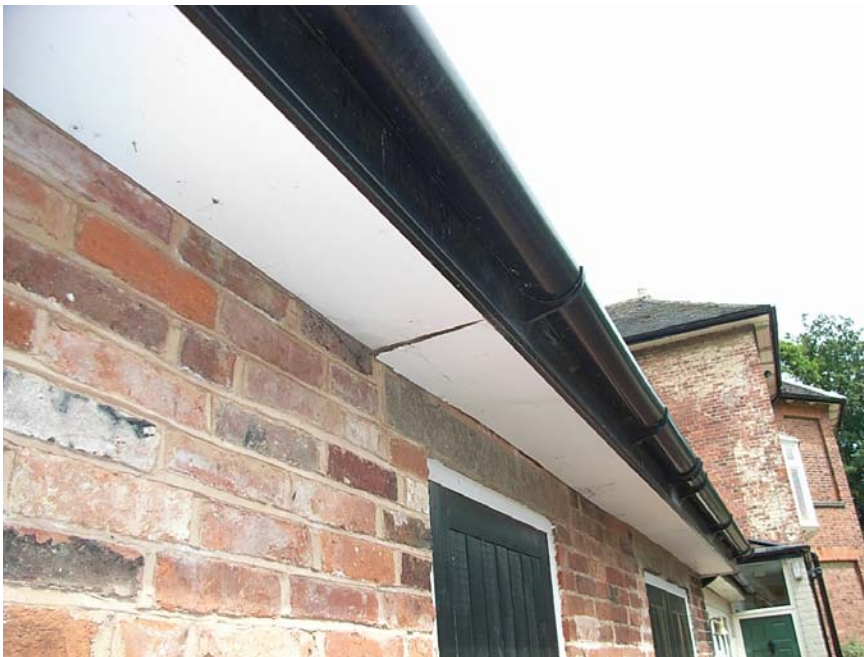
Dropping soffit.
